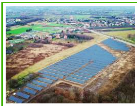
2 MW Dębica PL
